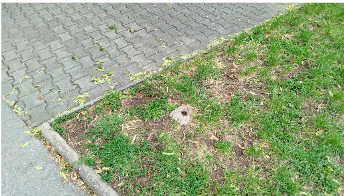
Fotografie stávajících obrubníků a zanechaných betonových patek po mobiliáři navržené k odstranění.
